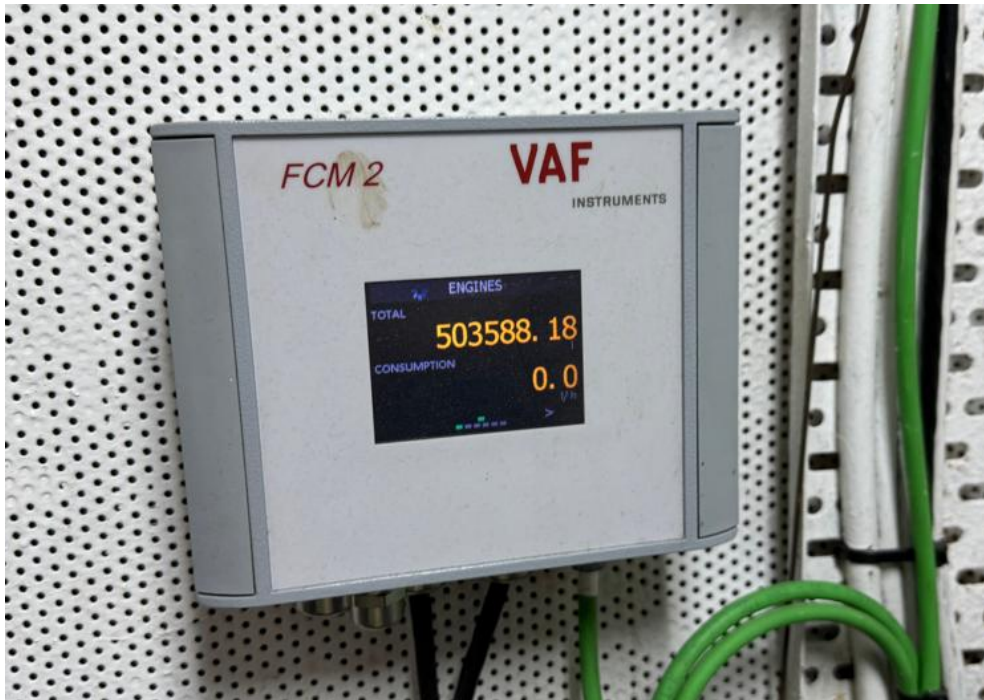
Figura 6. Medidor de consumo de la sala de máquinas. Total de litros consumidos (número de arriba) y consumo instantáneo (número de abajo)
