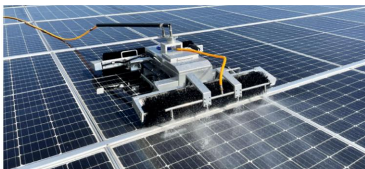
Figura 26. Robot de limpieza para los módulos fotovoltaicos (izquierda) (figura obtenida de Wu et al., 2024).
