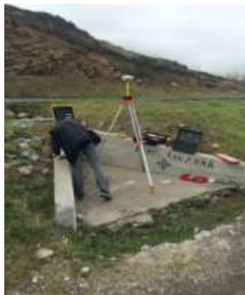
Figura 4. Sistema de posicionamiento instalado en tierra.
